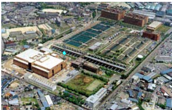
「村野浄水場 全景」
