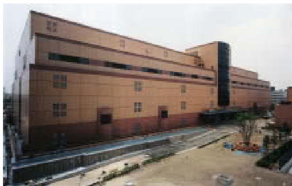
「高度浄水処理棟 全景」
